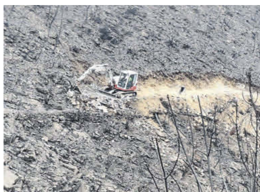
Una excavadora con los trabajos que se desarrollan en la zona.
